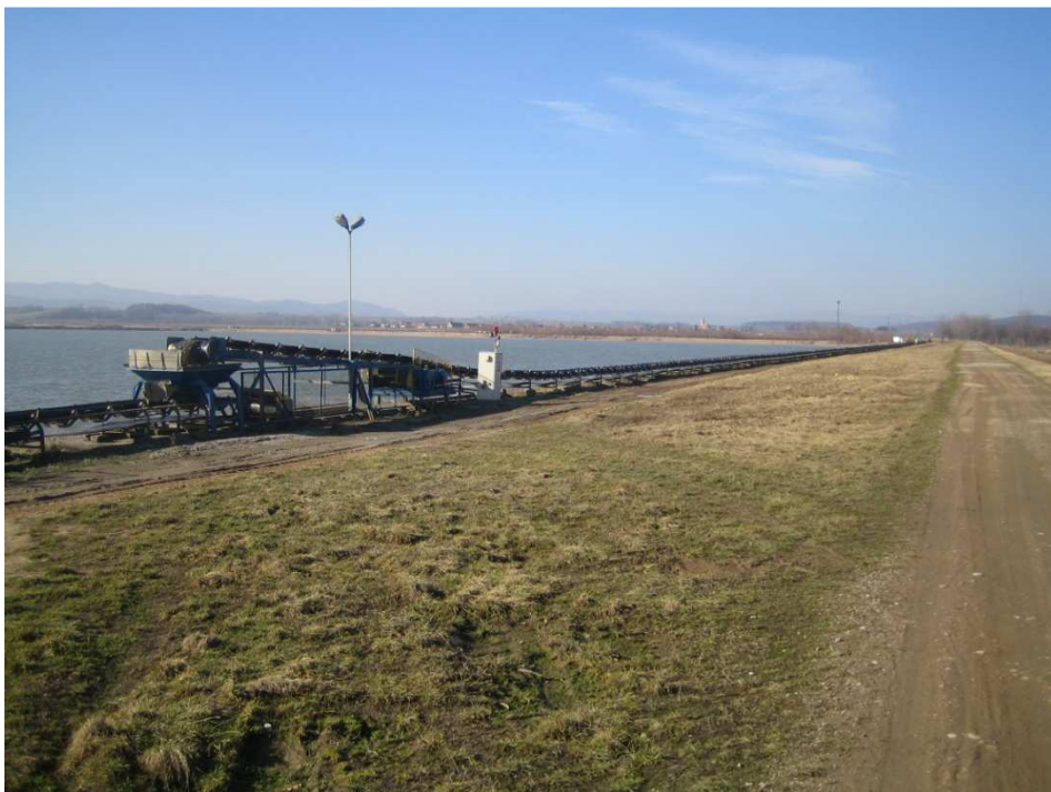
Fot. 3. Zbiornik Topola. Taśmociąg transportowy biegnący po lewej zaporze bocznej (fot. M. Sieinski)
