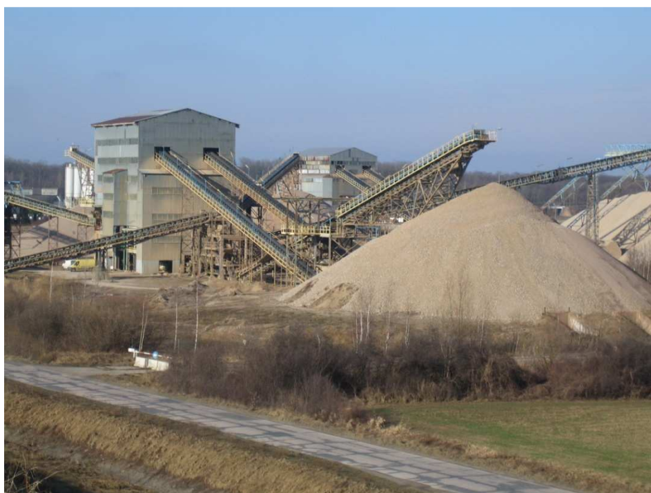
Fot. 4. Widok sortowni kruszywa wydobywanego ze zbiornika Mietków (fot. M. Sieński)
