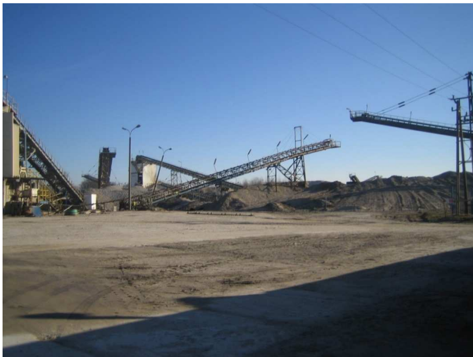
Fot. 1. Zbiornik Nysa. Taśmociągi w części składowania urobku (fot. M. Sieński)
