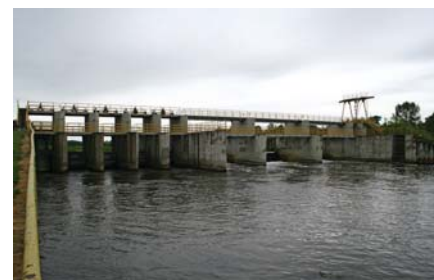
Jaz z małą elektrownią wodną na rzece Drwęce w Lubiczu Dolnym (fot. R. Stepnowski).
