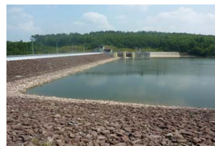
Zbiornik retencyjny Wióry na Świślinie, widok na zaporę ziemną i betonowy blok upustowy (fot. K. Mańk)
