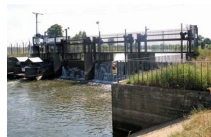
Mała elektrownia wodna przy jazu w Goryniów na Radomce (fot. W. Jaworski)
