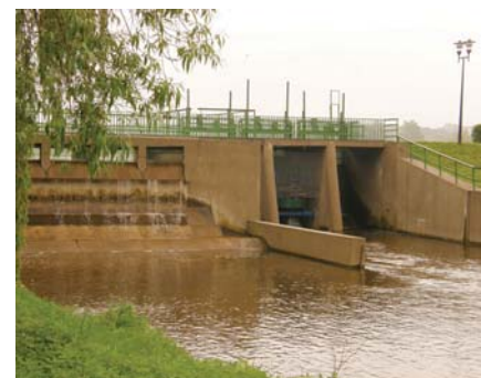
Dolna Wisła, jaz z przelewem bocznym piętrzącym wody zbiornika Mroźyczka (fot. R. Stepnowski)
