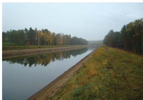
Kanał derywacyjny zaopatrujący w wodę EW Dychów (fot. A.Wita)
