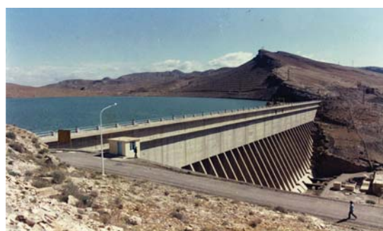
Zapora Ksob – podwyższona w 1976 r. (fot. W. Leszczyński)
