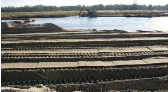
Hydrauliczne usuwanie rumowiska ze zbiornika (fot. S. Selerski)
