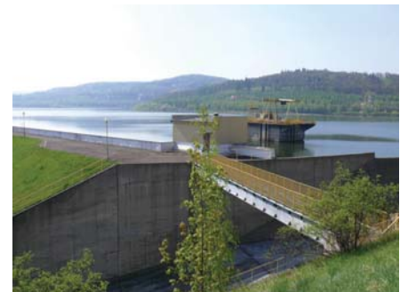
Dobromierz – sudecki zbiornik retencyjny (fot. S. Selerski)
