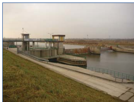
Żegluga „siłą sprawczą”. Stopień Smolice na Wiśle – widok na elektrownię (fot. K. Kulesza)
