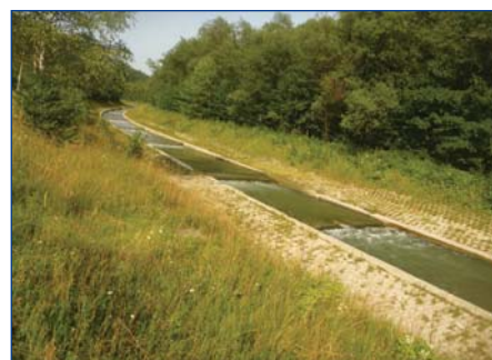
Koryto wyprostowane, o ujednoczonych strukturach i stałym spadku dna i brzegów - potok Wierchomlanka (fot. K. Czoch)
