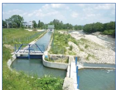
Mała elektrownia wodna na Czarnym Dunajcu w Koniówce – kanał doprowadzający wodę do MEW (fot. K. Czoch)
