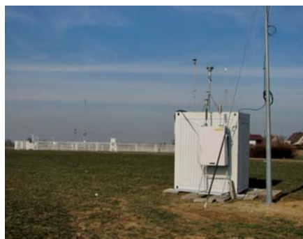
Stacja badawcza zanieczyszczeń powietrza na tle ogródka meteorologicznego stacji IMGW w Raciborzu (fot. E. Krajny)
